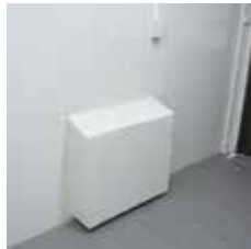
●吸い込み口フード（室内）
